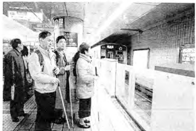
ホーム柵が設置された地下鉄東山線・栄駅
